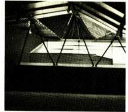
Abb. 6: Ausblenderaster im Bereich Oberlichtverglasung
